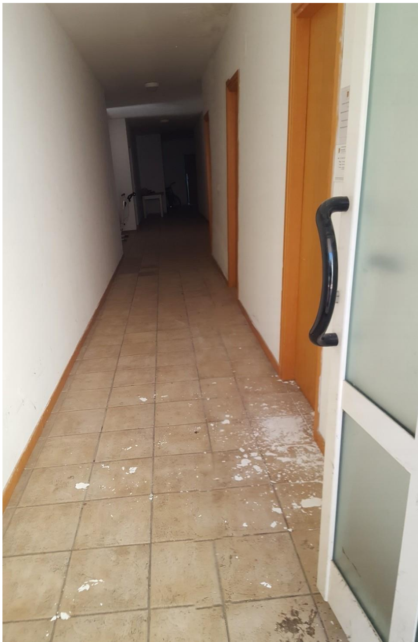
Ingresso e corridoio condominiale
